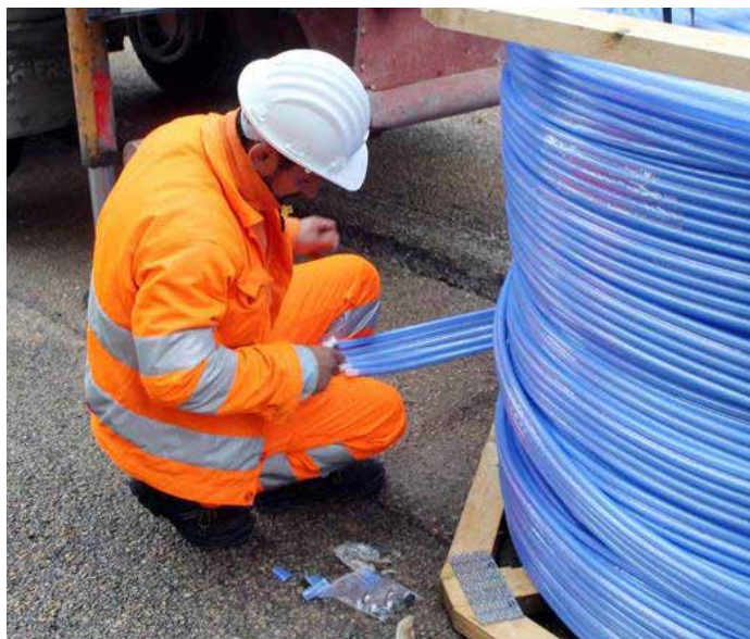
Tecnici all'opera a Mezzate per la posa dei cavi per la fibra ottica
