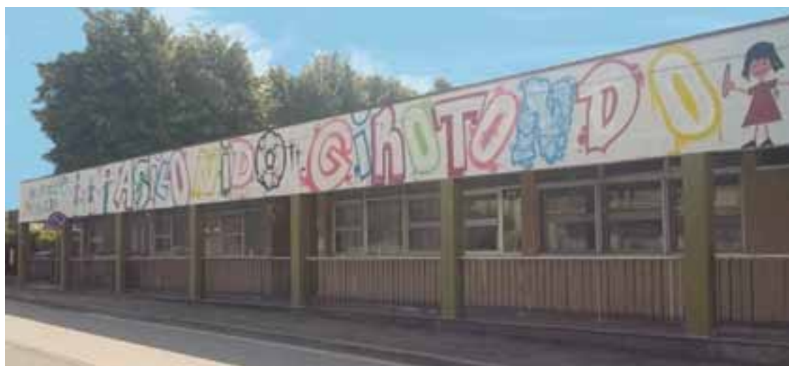
All'asilo Nido “Il Girotondo” e in altri due edifici scolastici sono già stati effettuati i lavori previsti.
