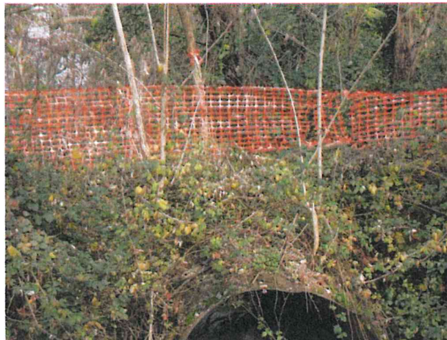
Figure 3 Ponte e rete sul cavo Marocco
