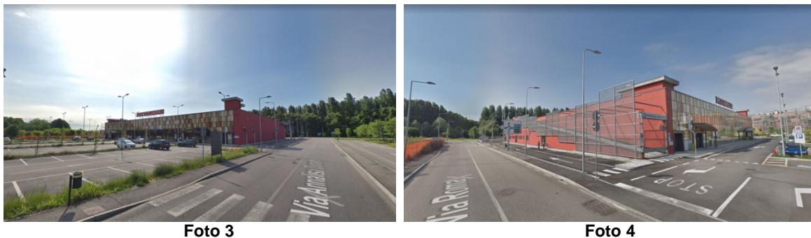
Fig. 03.3. – Riprese fotografiche dell'area e dell'edificio esistente Fonte: Google Maps
