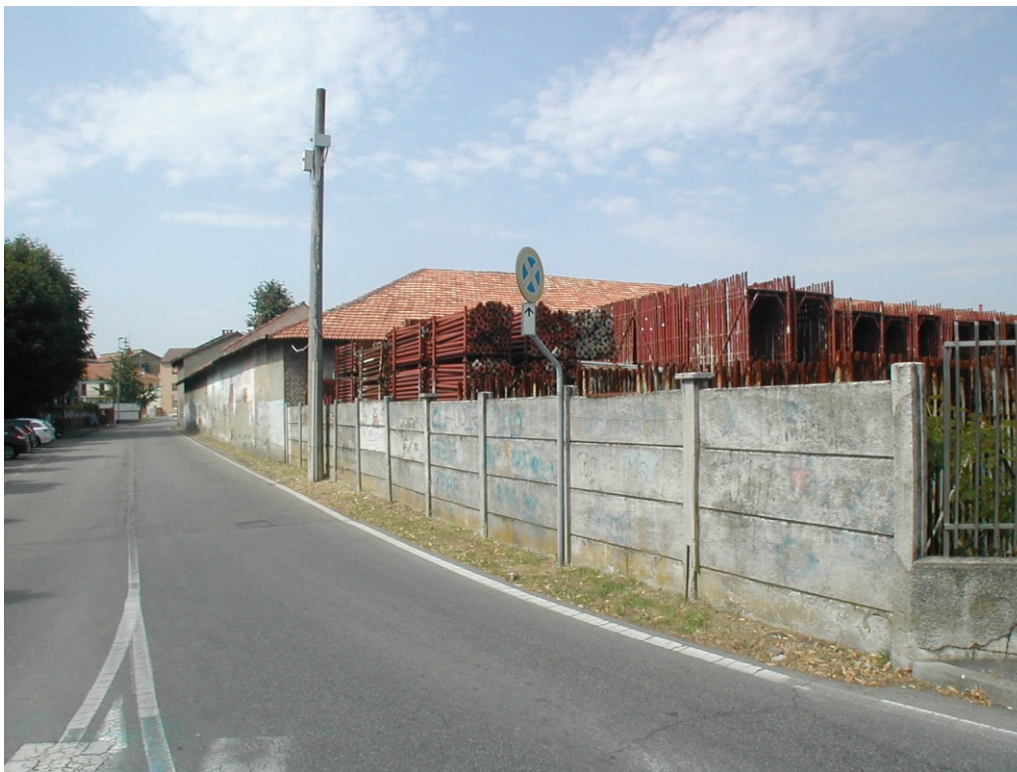
foto 3: vista dell'attuale recinzione ed allineamento edifici da demolire lungo la Via Matteotti
