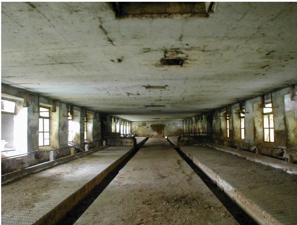
foto 1: interno stalla piano terreno
