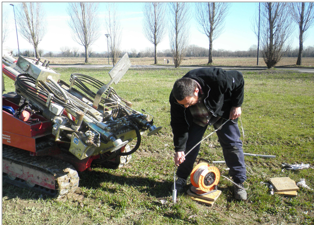
Misura della quota piezometrica.
